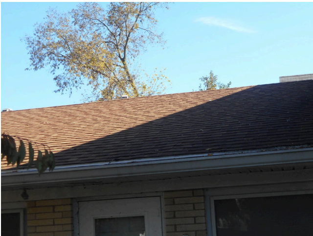
19. Asphalt shingle tiles
